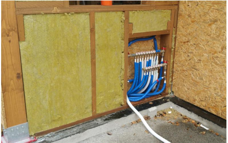
L'impianto è realizzato con tubi in multistrato incamiciato per il passaggio delle acque e tubi in PVC per gli scarichi il tutto completo in ogni suo onere e magistero, nell'impianto sono previsti n. 4 punti acqua per ogni vano bagno, n. 1 punto acqua per vano cucina.
