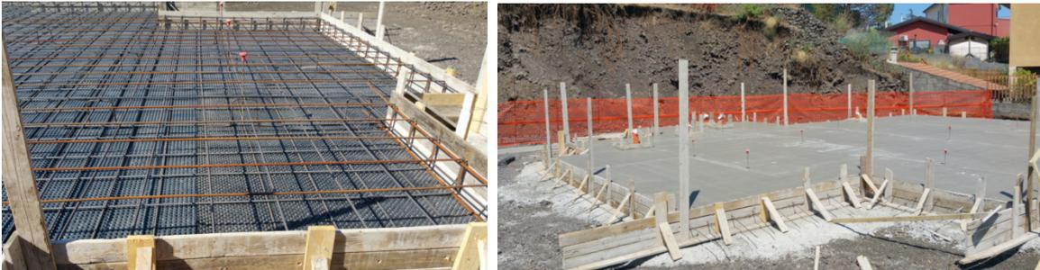
Le fondazioni per le case fisse con struttura in legno saranno del tipo continue così come indicato per le zone sismiche, a travi rovesce o a platea e saranno costruite con conglomerato cementizio avente classe di resistenza non inferiore a C25/30 ed armatura in acciaio a barre ad aderenza migliorata del tipo B450C.
